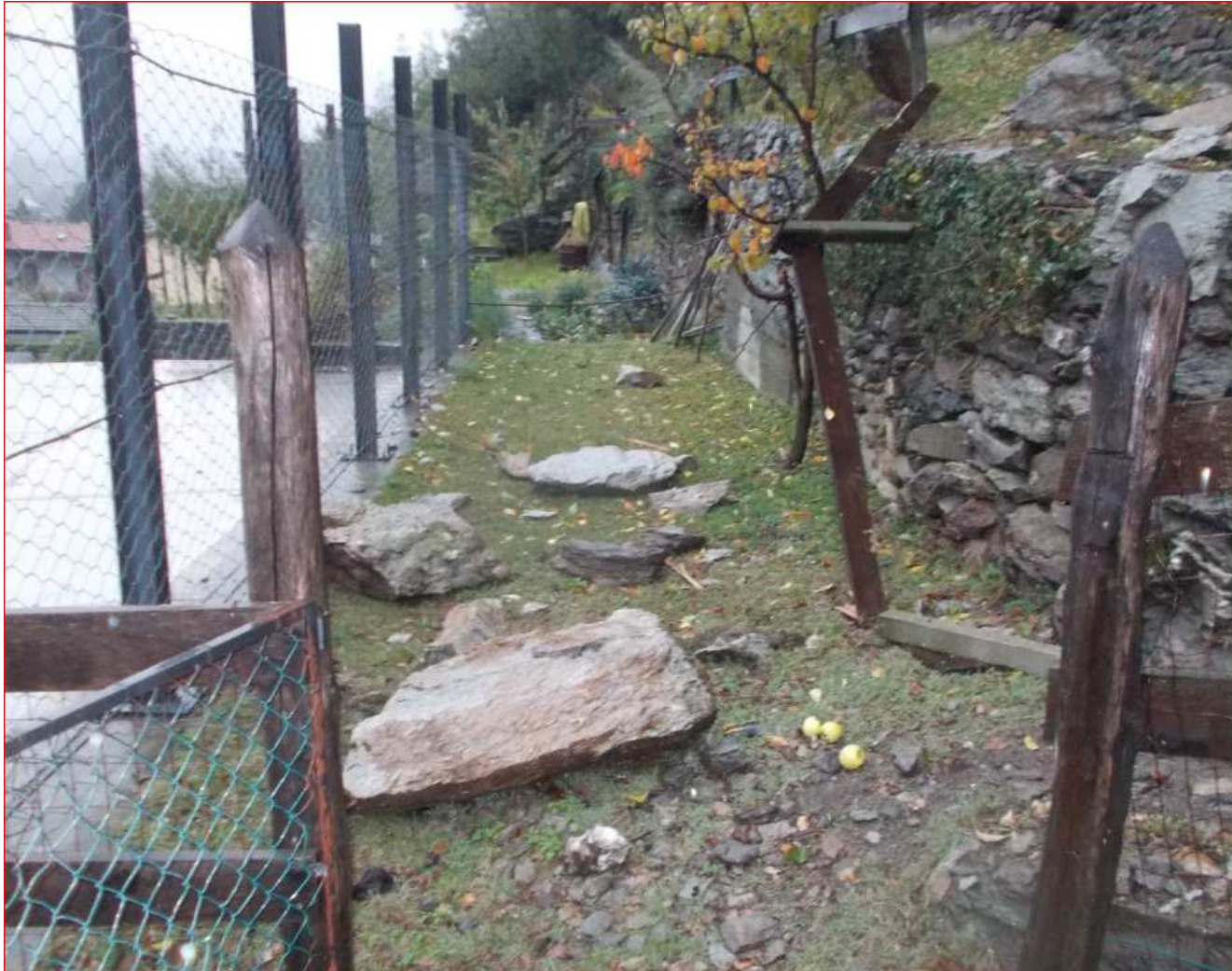
Massi caduti dietro ad un'abitazione in Comune di Arnad
