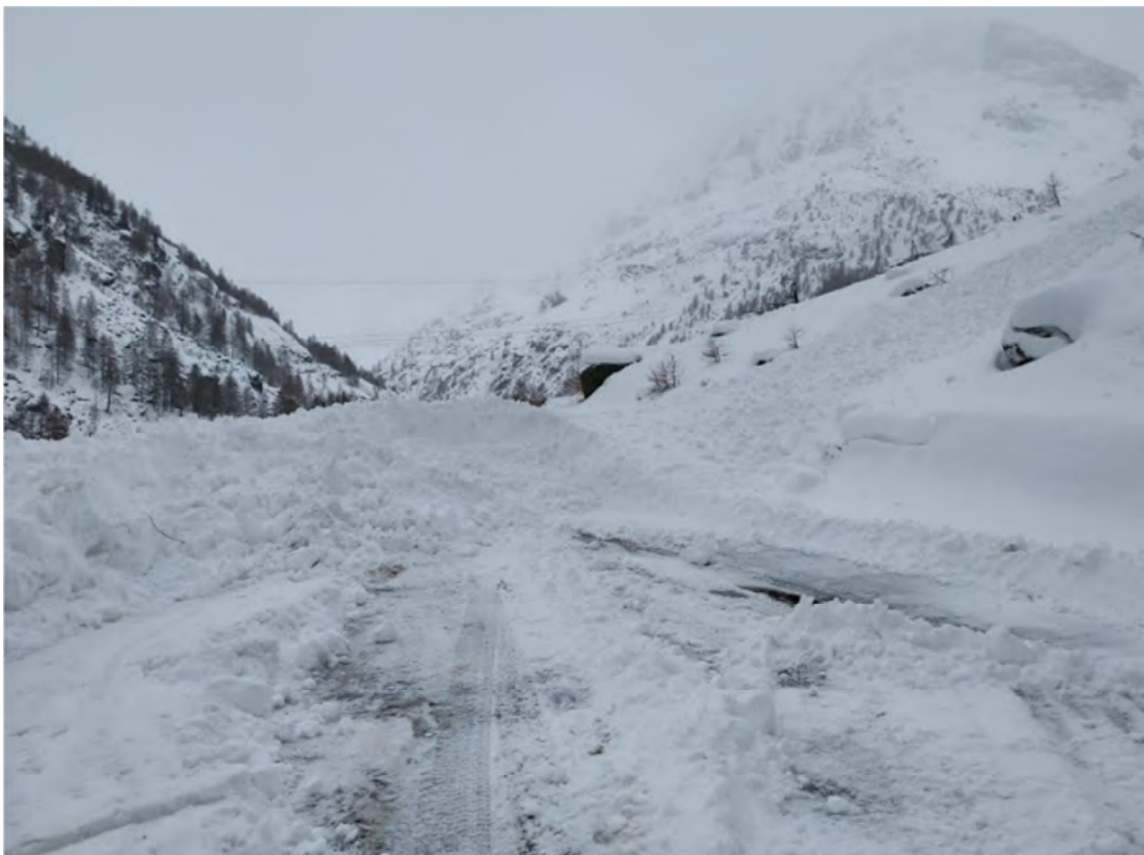
Figura 39: 30 gennaio, una valanga poco prima di Pont di Valsavaranche raggiunge la sede della strada regionale.
