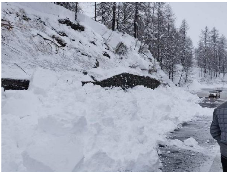
Figura 45: Distacco a monte della scarpata stradale su S.R. 46 che porta a Cervinia (Valtournenche), nei pressi del Lago Blu del 30 gennaio.
