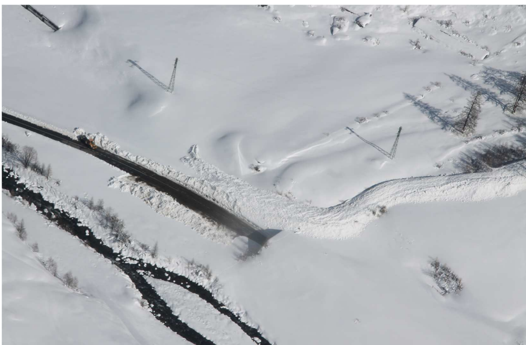
La valanga 14-049 detta "Lorguibet" (Rhêmes-Saint-Georges) scesa nelle prime ore del 4 marzo a conclusione della nevicata. La parte finale dell'accumulo ha raggiunto la strada regionale all'imbocco della galleria, impedendo il passaggio dei veicoli. Nello scatto fotografico del 4 marzo si nota un mezzo pesante intento a sgomberare la sede della strada regionale. L'ultimo evento di magnitudo simile risale al 16/03/2011 quando la valanga ha raggiunto la strada regionale.
