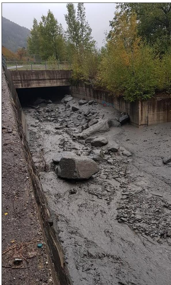
**Morgex, T. Rouillard colata detritica riempie l'alveo del torrente ostruendo parzialmente attraversamento sotto strada comunale.**
