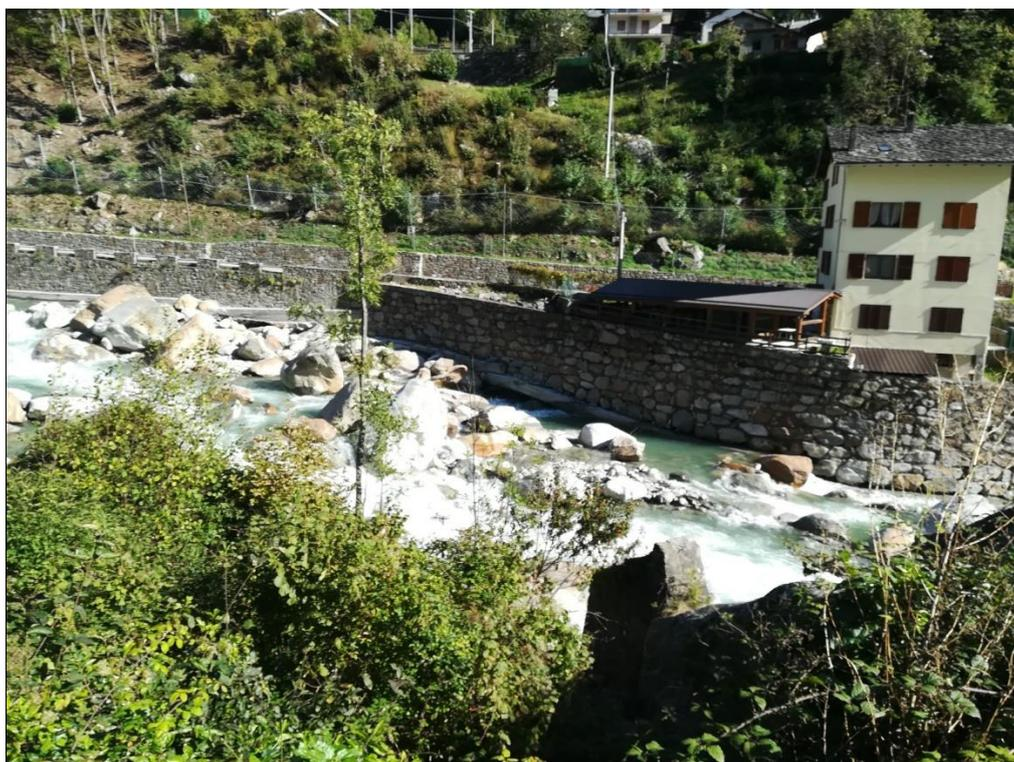
**Fontainemore, erosione spondale T. Lys in loc. Versa e sotto-escavazione arginatura nei presi di un fabbricato esistente.**
