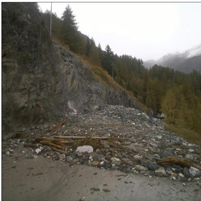
**Cogne, debris-flow lungo impluvio delle miniere di Colonna ostruisce la strada comunale per Lillaz**
