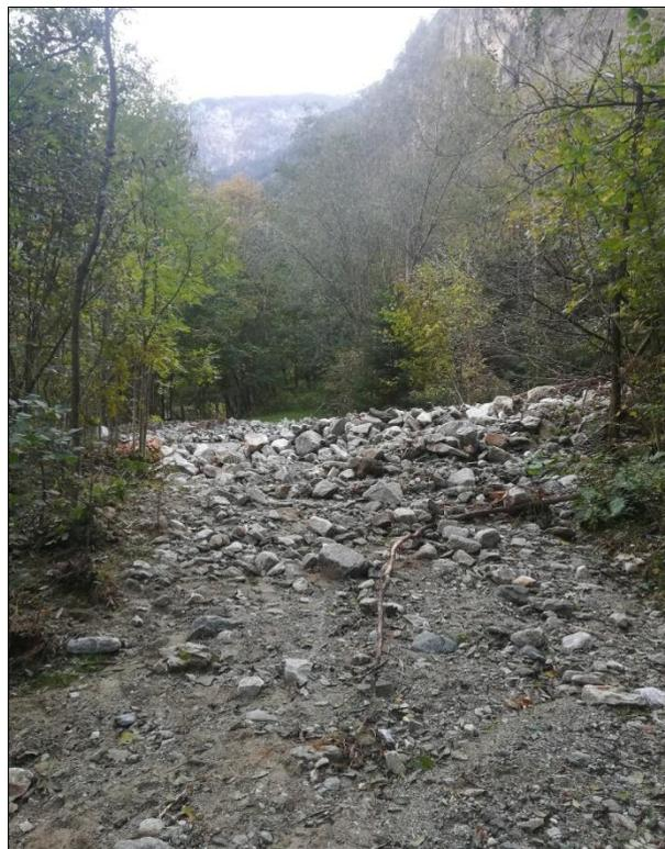
**Gaby, debris-flow lungo impluvio di Rickard interrompe strada poderale.**
