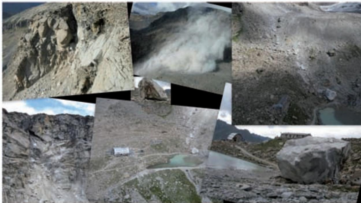
FIG. 73: immagini riguardanti il dissesto: il settore di distacco, il blocco di dimensioni imponenti, il percorso fatto e la nube alzata da una successiva caduta massi.
