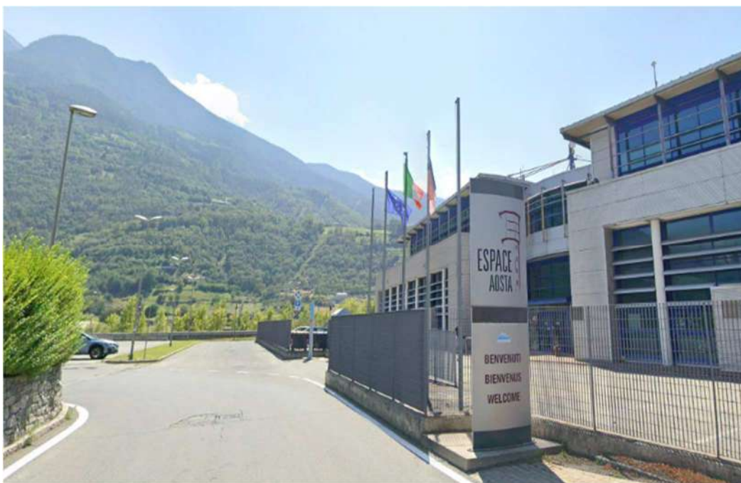
Figura 19 - Accesso Espace Aosta
